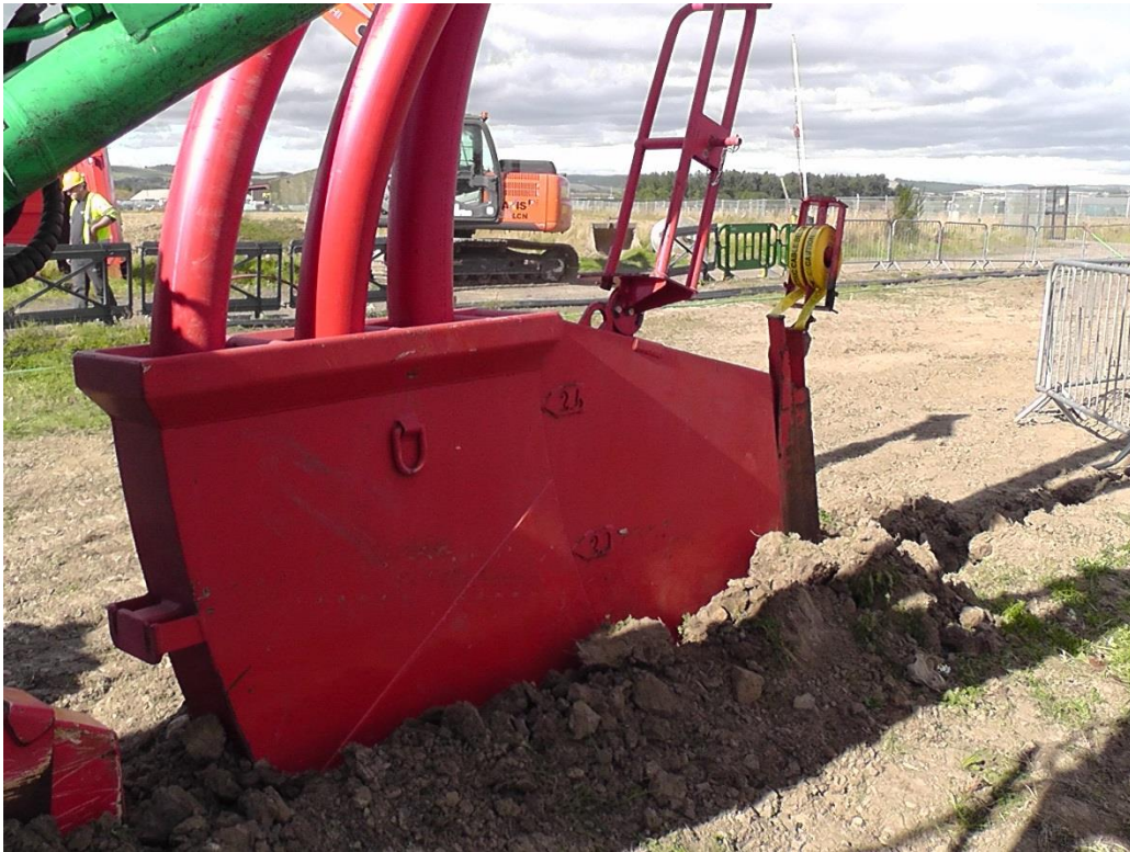
Verlegen mit Einbaukasten
