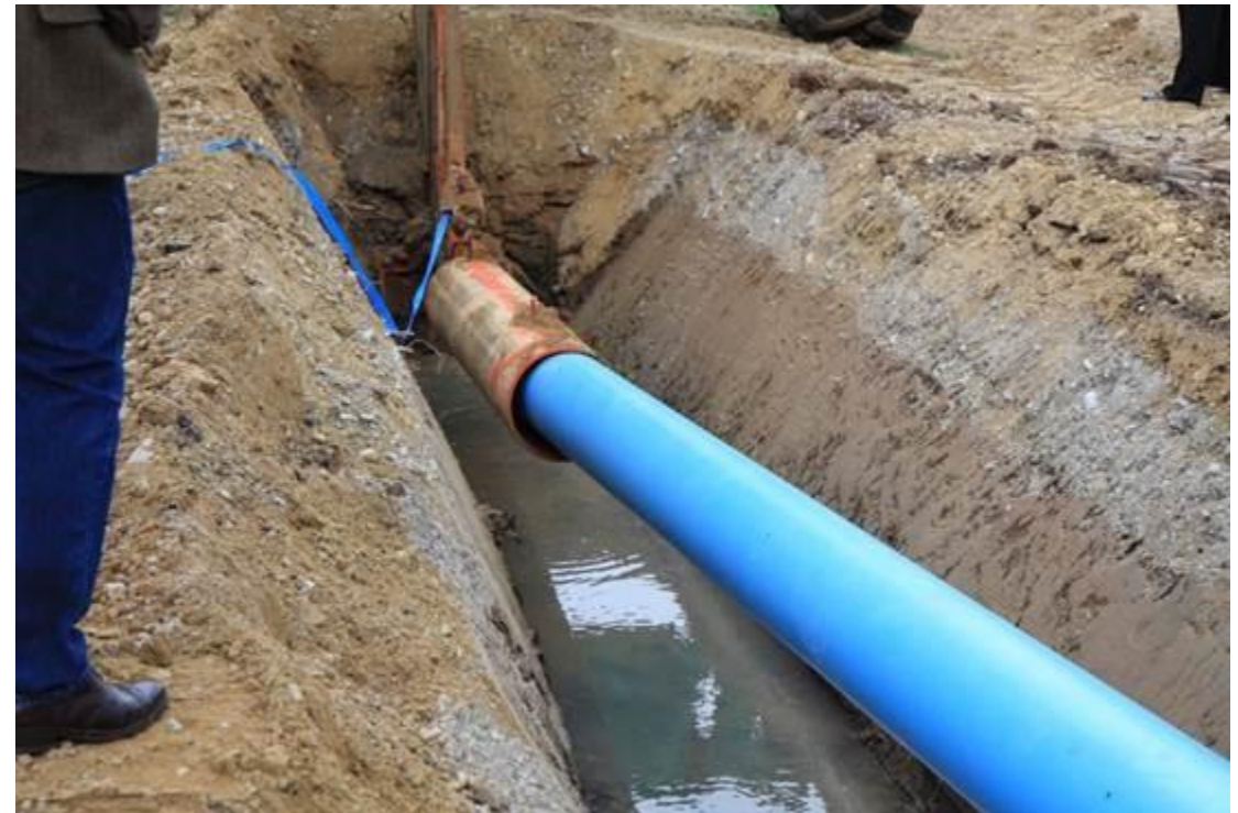
Verlegung Nachziehverfahren
